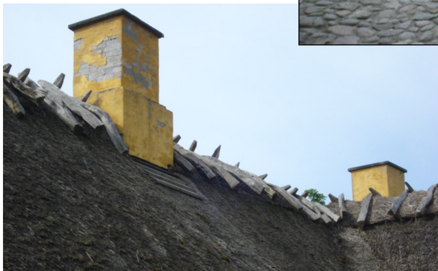
Skorstene, vandbrædder og rygning med flæk- kede rygtræer. (nedenfor)
