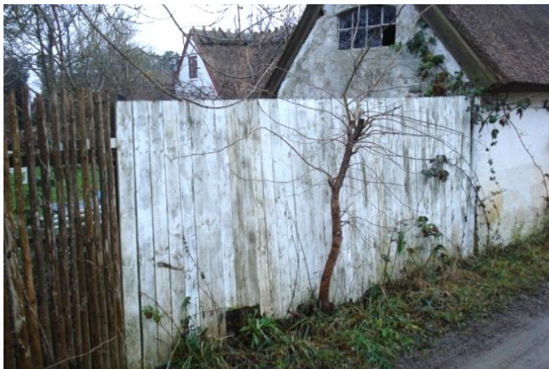
Ældre plankeværk, der er opsat som forlængelse af en facade, inden der går over til et lettere hegn. Her er plankeværket malet kridt for visuelt at fremhæve sammenhængen med bygningen. Der er vandret afslutning i bund og top.
