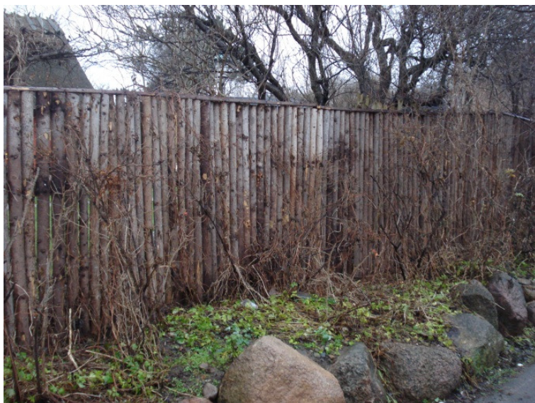
Hegn af samme type men med overlægger og "løftet" op fra vejniveau ved en lav stensætning.
