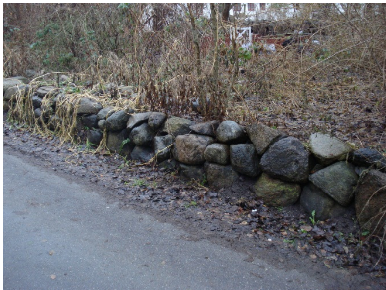
Lavt stengærde med to til tre rækker større marksten Dette gærde er ikke fuget ud med beton. Gærdet fremstår meget organisk.
