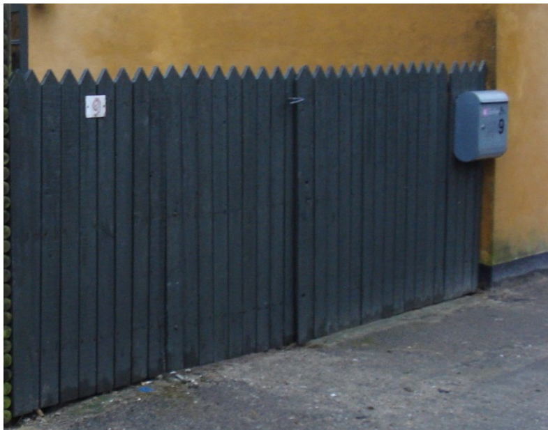
Plankeværk med låge. Trekantet afslutning i top og vandret i bund. Plankeværket fungerer perfekt som en lavere forlængelse af husets facade mod vejen, og muliggør et kik ind på ejendommen.
