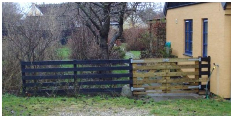
Plankeværk med vandretliggende brædder. Lågen er forsynet med skråstiverne på havesiden og tydelige beslag.
