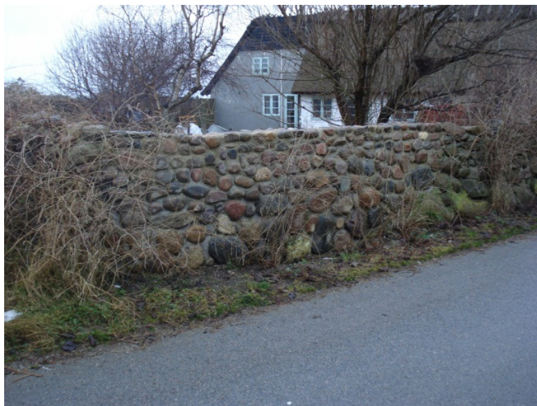
Højt stengærde med otte til ni rækker marksten Dette gærde er fuget ud med beton i dele af gærdet.
